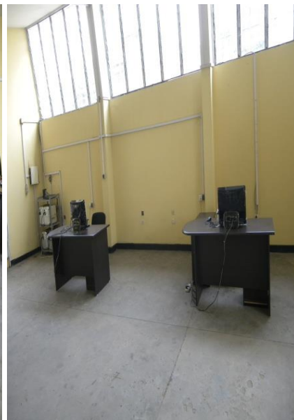
Après l'intervention de Sattel
