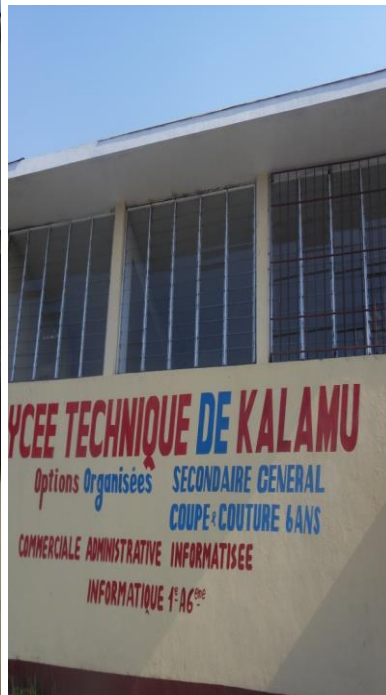
Après l'intervention de Sattel
