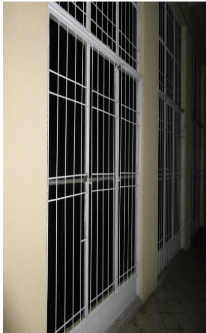
Après l'intervention de Sattel
