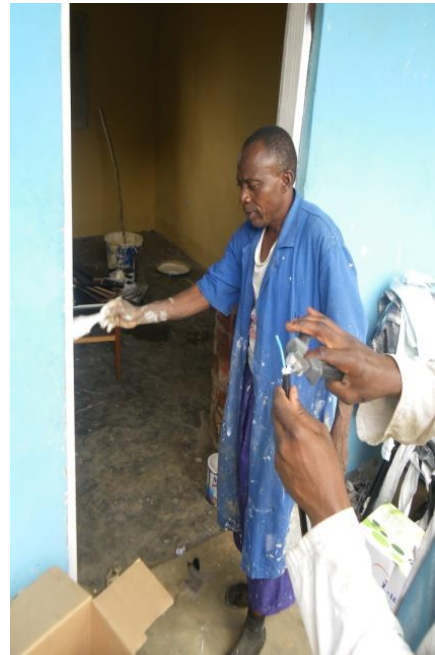
Travaux de réhabilitation par Sattel
