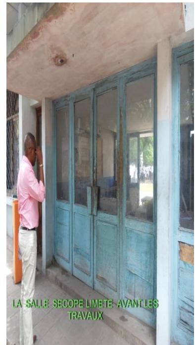
Avant l'intervention de Sattel
