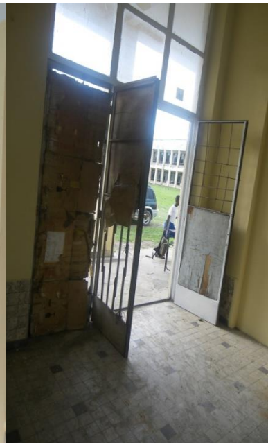
Avant l'intervention de Sattel
