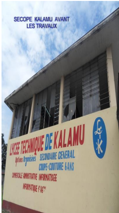
Avant l'intervention de Sattel
