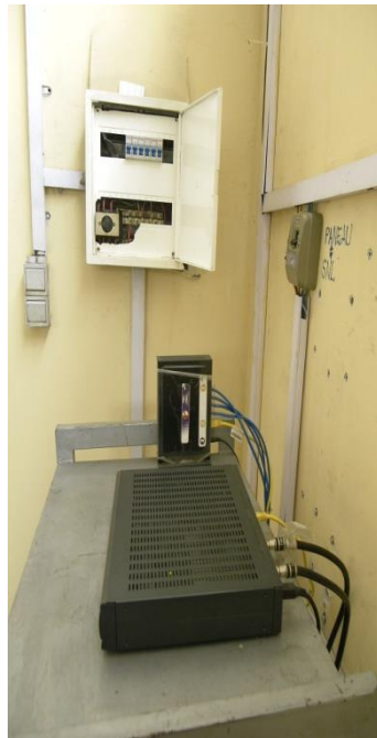
Après l'intervention de Sattel
