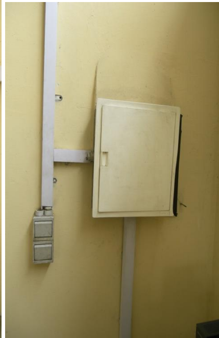
Après l'intervention de Sattel
