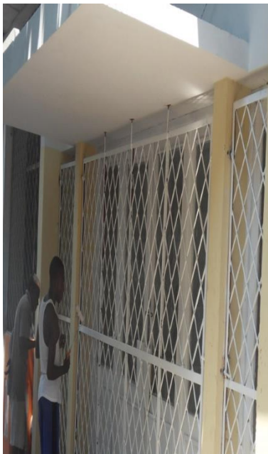
Après l'intervention de Sattel
